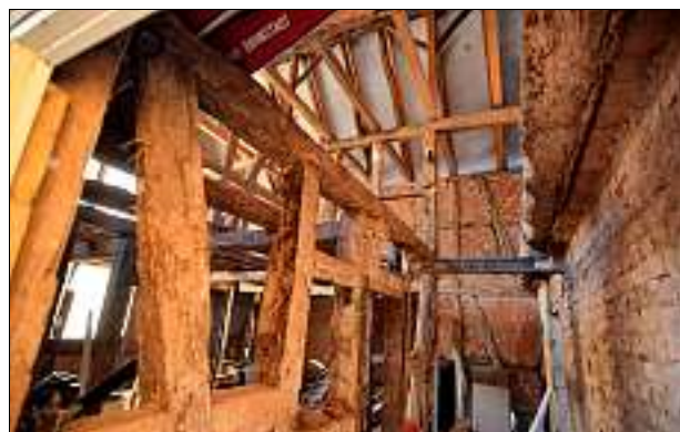
Die alten Gebäude der Mühle bestehen momentan nur aus dem Fachwerkgerüst, den Außenwänden und dem Dach.
